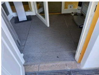
Eingangsbereich mit Windfang
